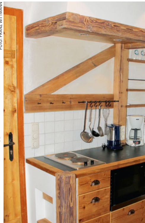
Nur alte Holzteile: ein Teil unverändert, ein Teil als Bretter aus Balken geschnitten und für die Küchenfronten verwendet.
